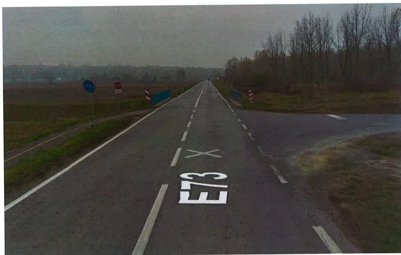
Fotografija 3: - postojeće stanje (sa sjeverne strane)
