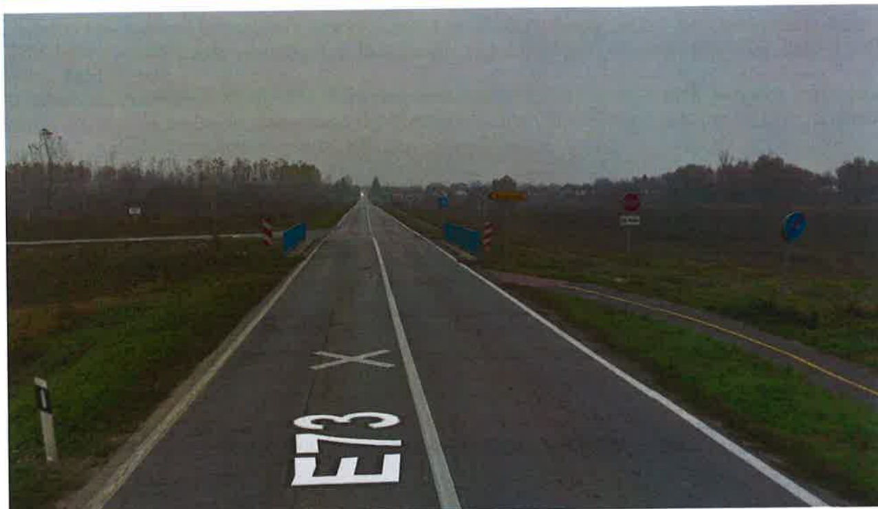
Fotografija 2: - postojeće stanje (s južne strane)
