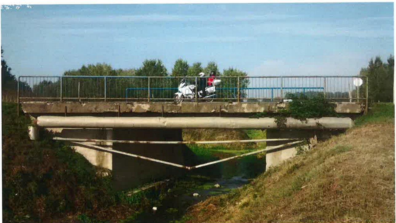
Fotografija 1: - pogled na postojeći cestovni most (s istočne strane)
